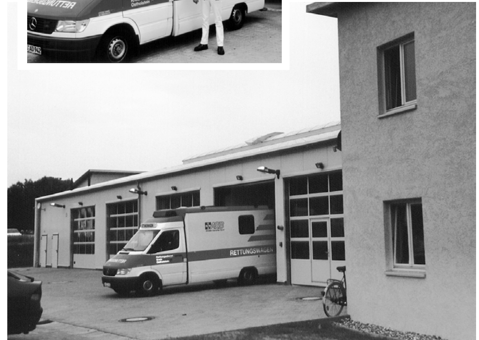
Ein Rettungswagen verläßt die Fahrzeughalle der neuen Heiligenhafener Wache.
