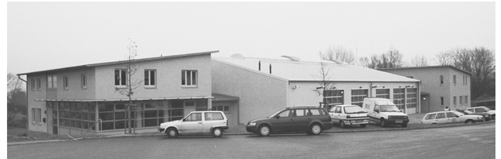
Gesamtansicht des neuen ASB-Gebäudes in der Tollbrettkoppel 15 in Heiligenhafen.
